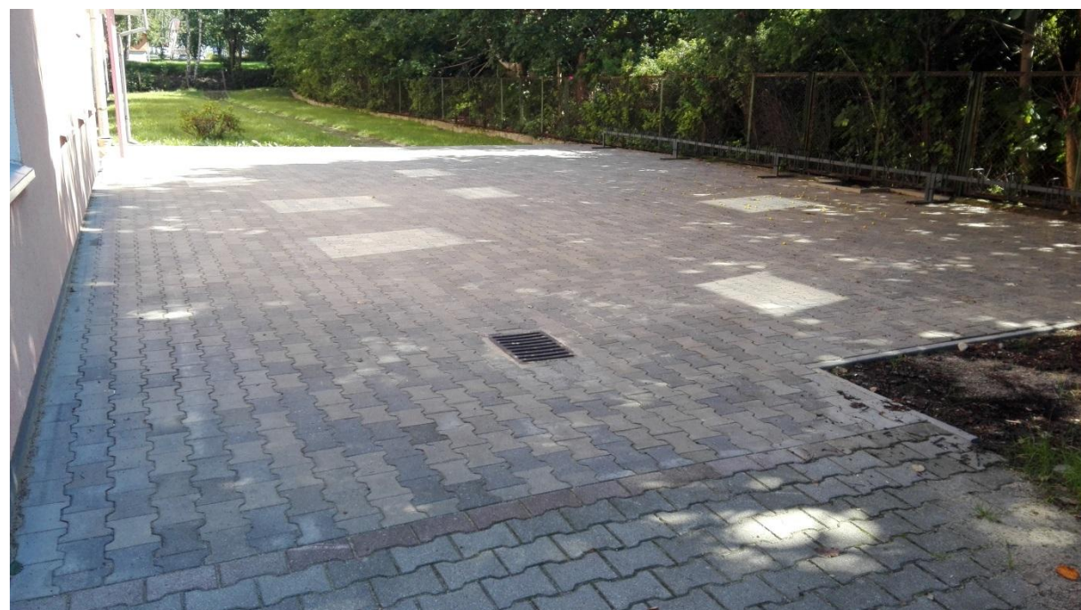
Fot. 7. Wykonanie kostki betonowej przed budynkiem Internatu w ZSO w Bytowie.
