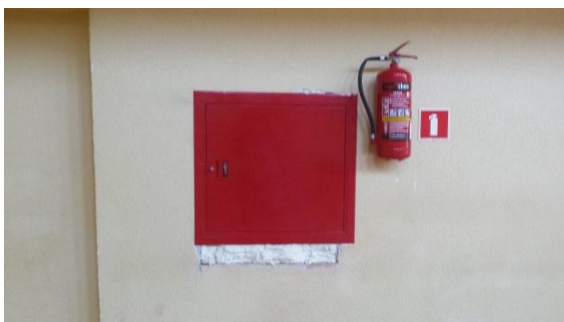
Fot. 2. Wymiana hydrantów w ZSO w Bytowie
