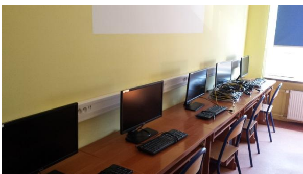
Fot. 3. Wymiana instalacji elektrycznej w ZSOiT
