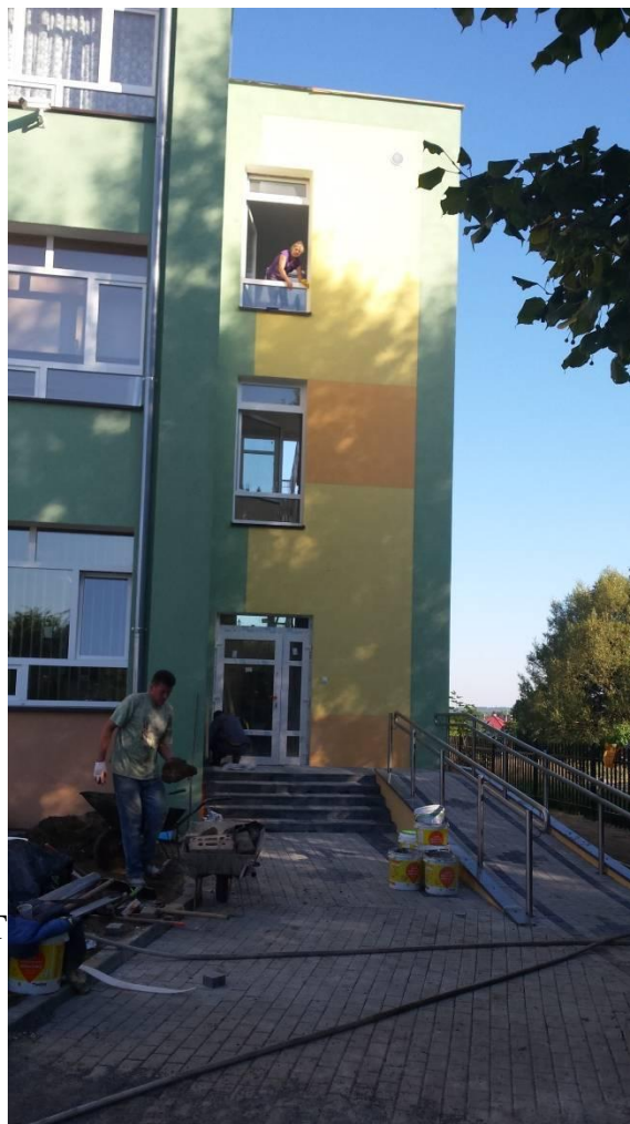
Fot. 4. Winda i ciąg komunikacyjny w ZSOiT w Miastku
