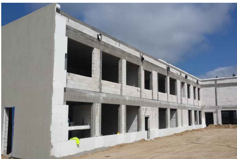
budowa nowego obiektu PCEZ w Bytowie
