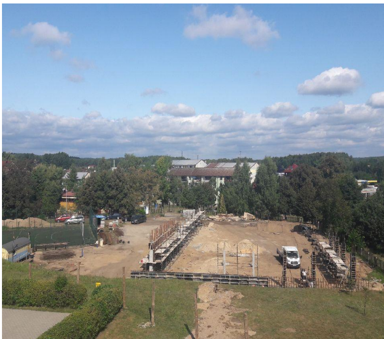
budowa sali gimnastycznej przy ZSOiT w Miastku
