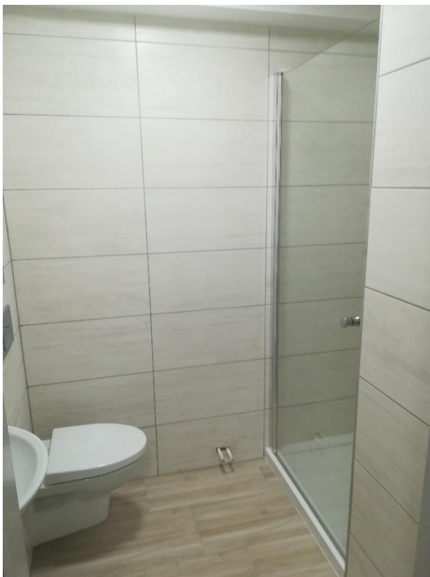
wyremontowane toalety w internacie ZSO w Bytowie
